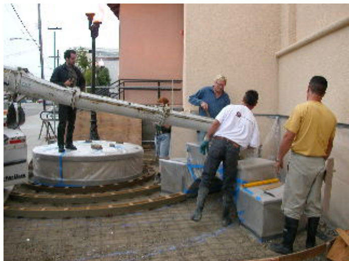
Volunteers pour concrete
